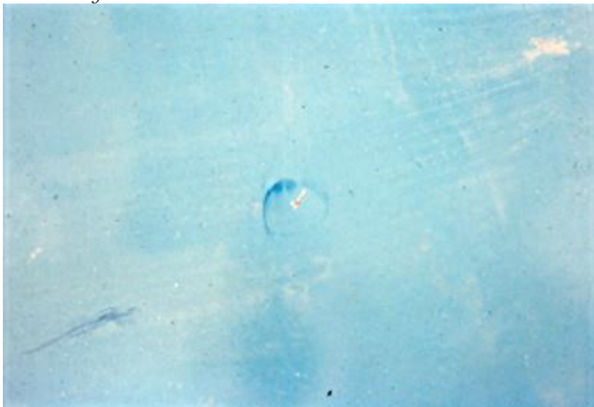
Рис.7А. Повреждения на крыше, фото одной из вмятин
