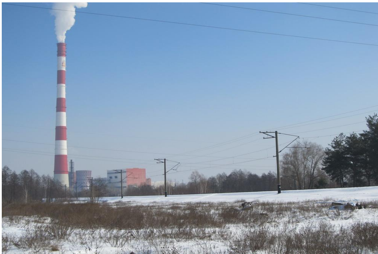
Рис.25.Район исследований ж/д полотна вид сбоку и ТЭЦ-5.
