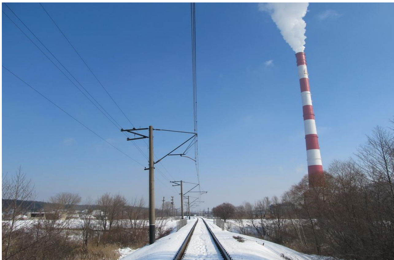
Рис.15.Район моста и труба ТЭЦ-5.
