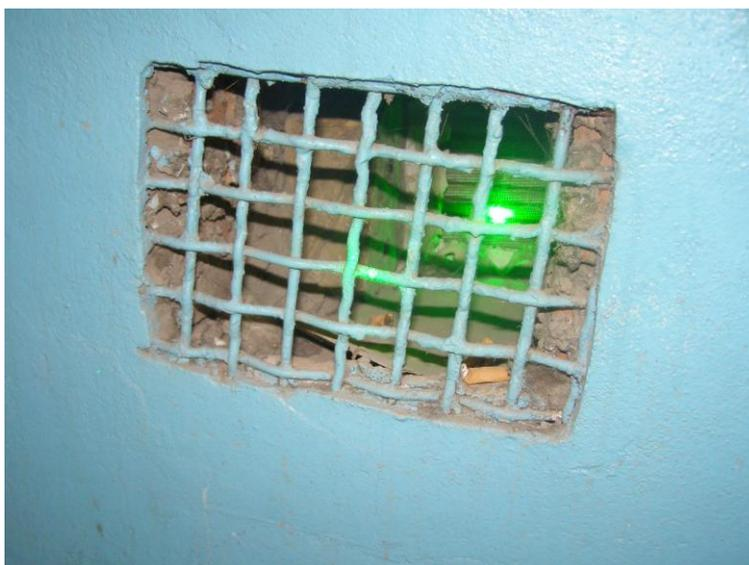
*Внутренние квартирные воздуховоды, подсвеченные лазером УНДЦА «ЗОНД»*
