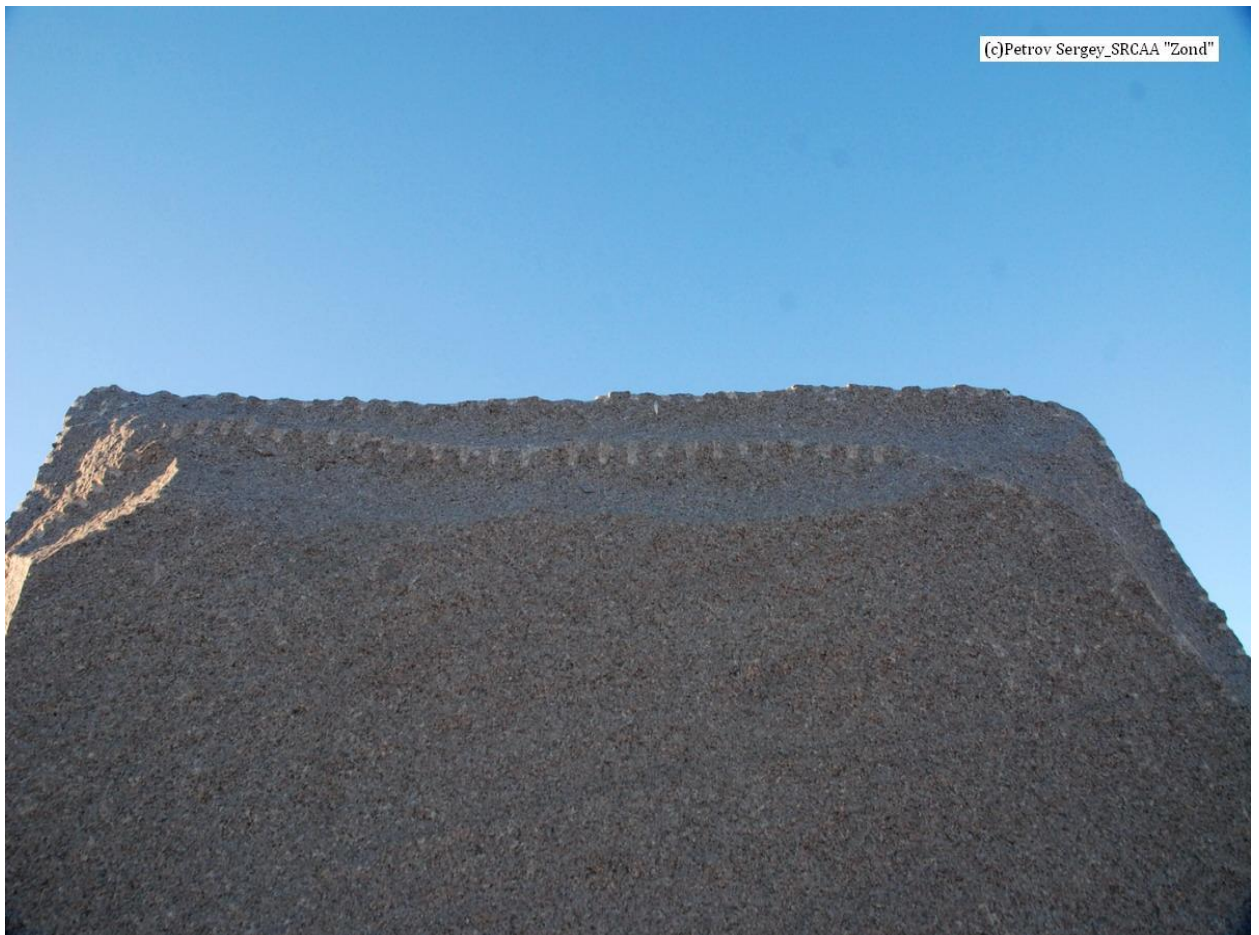
Рис. 195 Фото шаговых насечек от отбойного молота по краям гранитного монолита.
