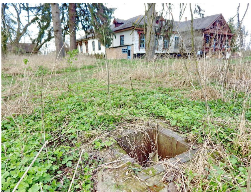
Рис.34.Один з чотирьох автентичних водовідводних ємностей-накопичувачів. Фото Клименка Р.О.
