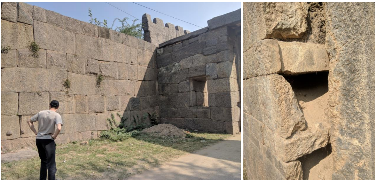
Рис.3. «Полігональне мурування» є насправду не із суцільних блоків а плитно-тичковим і вочевидь відноситься до пізнішого середньовіччя
