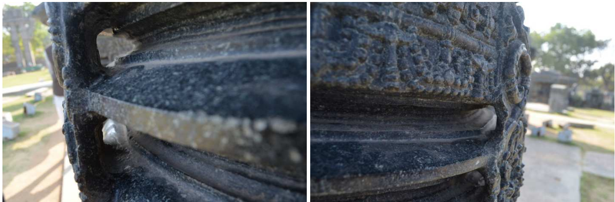
Рис. 5.2.10. Колова обробка колони із нанесенням орнаменту, має локальні геометричні нерівності у місцях проходження інструменту
