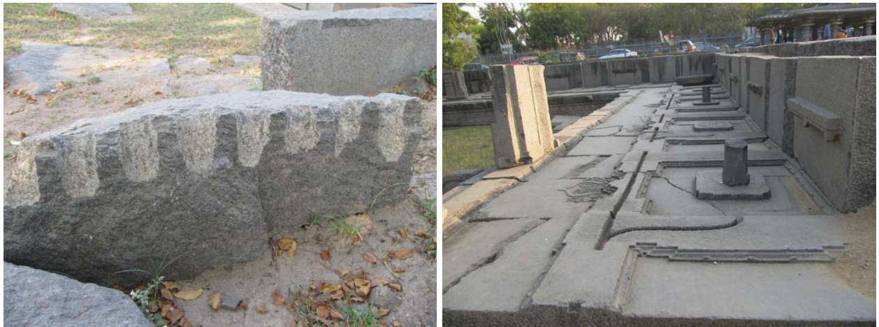
Рис. 5.2.14. Сліди пізнішої обробки, нового використання, руйнування споруд
