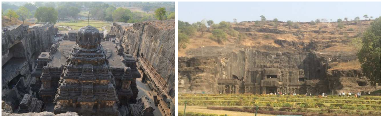
Рис.5.1.3. Загальний вигляд зверху та по головному фасаду храму
