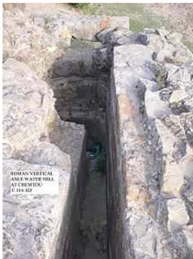
Рис. 7.3.18. Римський турбінний млин в Хемтоу, Туніс. Бічний приплив води до млину змушував горизонтальне колесо у валі повертатися, тобто це справжня, найдавніша відома турбіна [42]; Еоліпіл або куля Герона античної доби – найдревніший знаний паровий двигун [29]
