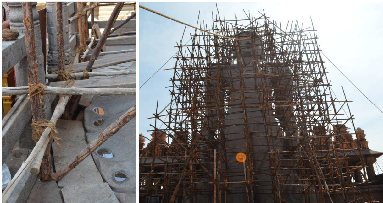
Рис. 5.5.4. Розширена видима межа постаменту (надалі закрита плитками підлоги двору храму); статуя на момент дослідження (із риштуваннями для реставрації)
