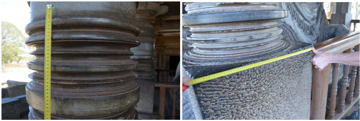
Рис. 5.6.5. Обертові форми колон у храмі; нерозривність цілковитого елемента колони із основи із слідами ручної грубої обробки, можливі сліди початку різку
