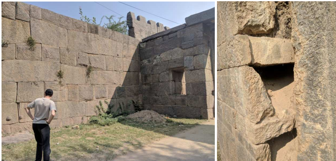
Рис. 5.2.5. Мурування пізніших конструкцій фортифікації з тичково-поперечною схемою улаштування відносно тонких плит та засипкою ґрунтом.
